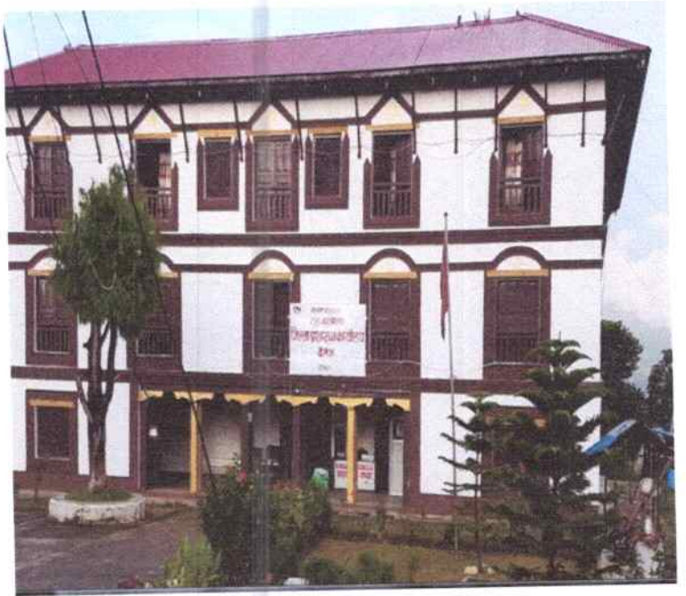
जिल्ला प्रशासन कार्यालय, दैलेखको भवन
