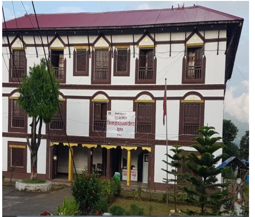
जिल्ला प्रशासन कार्यालय, दैलेखको भवन
