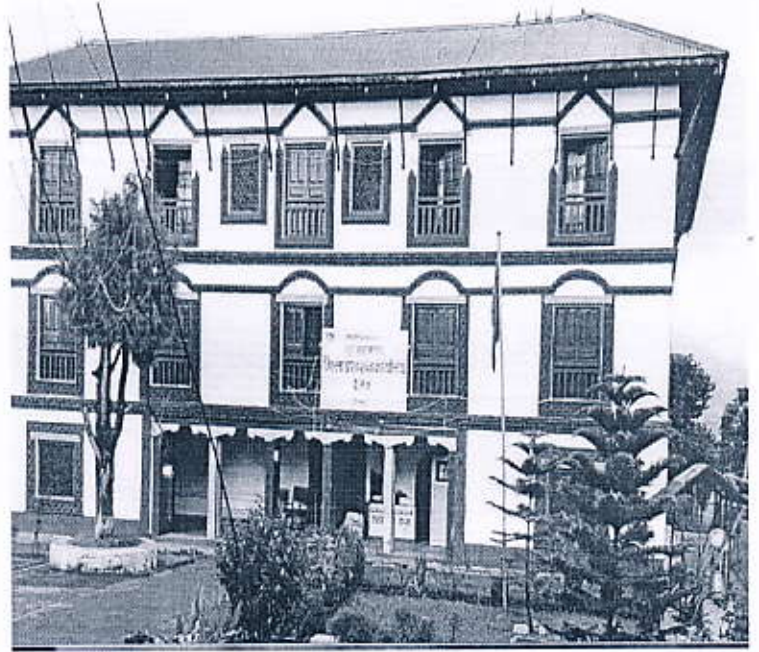
जिल्ला प्रशासन कार्यालय, दैलेखको भवन
