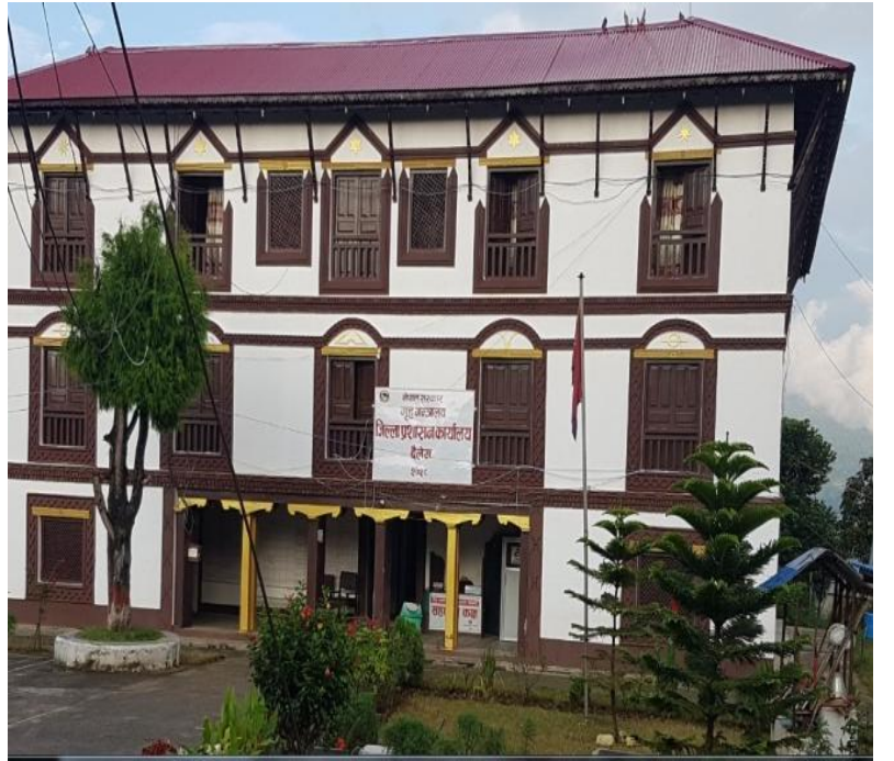
जिल्ला प्रशासन कार्यालय, दैलेखको भवन
